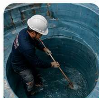
Mantenimiento de cisternas.
