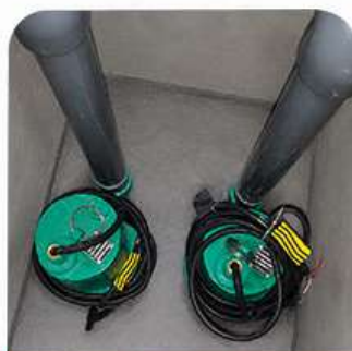
Mantenimiento de bombas sumergibles.
