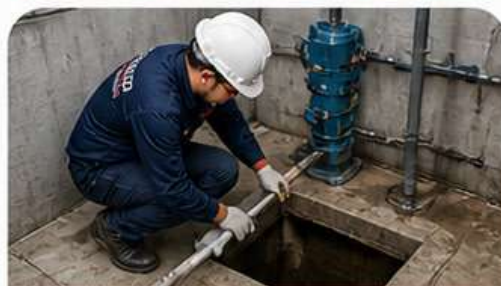
Mantenimiento de pozo sumidero.
