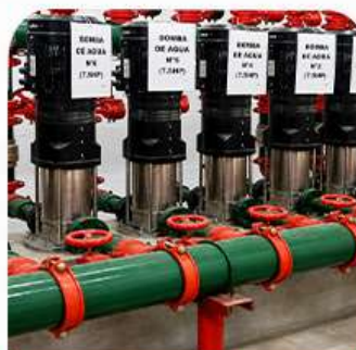
Mantenimiento de bombas de agua.
