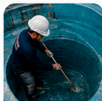
Mantenimiento de cisternas.
