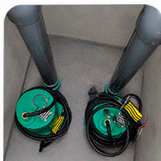
Mantenimiento de bombas sumergibles.
