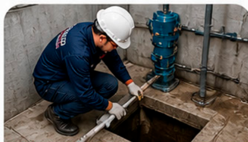
Mantenimiento de pozo sumidero.
