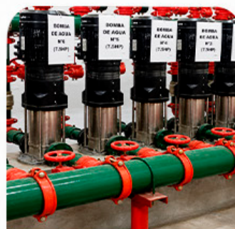
Mantenimiento de bombas de agua.
